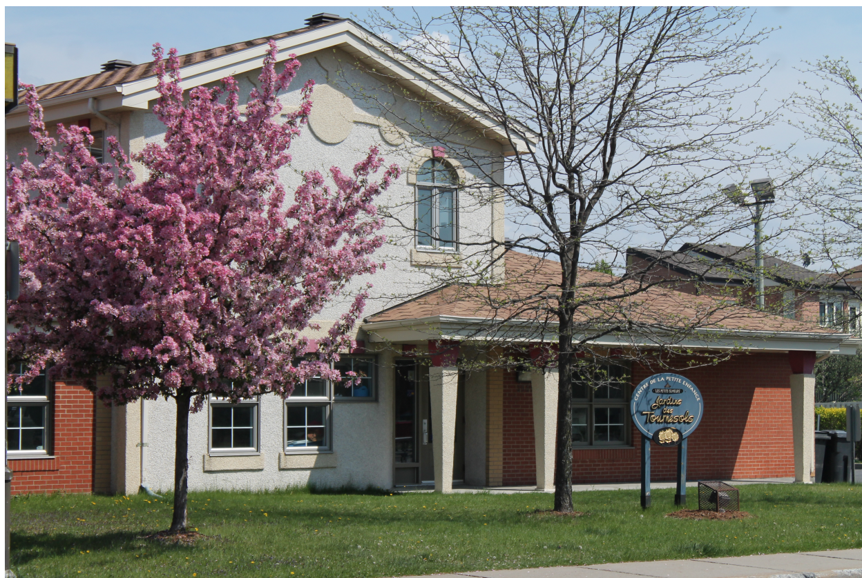
Installation Le Jardin des Tournesols rue Pierre-Thomas-Hurteau
